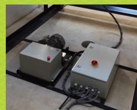
Das Aggregat und der Schaltschrank können wahlweise unterhalb der Plattform oder in einem separaten Betriebsraum untergebracht werden
